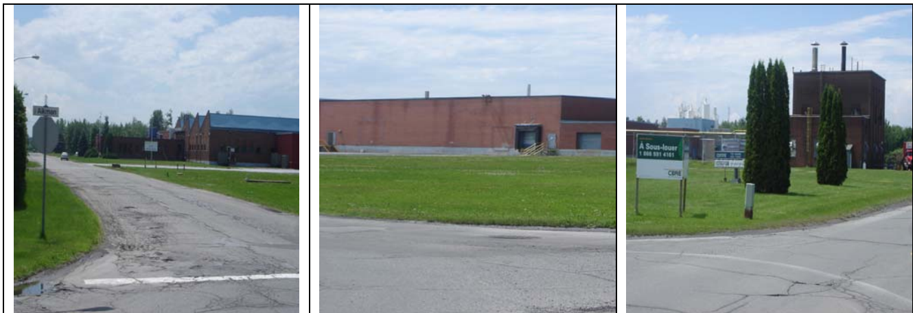
Immeuble à sous-louer à Farnham (ancien Aikman-Collins)
