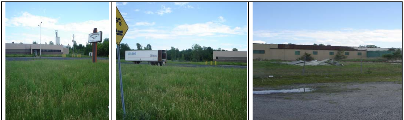
Bâtiment du 1161, boulevard Industriel à Farnham
