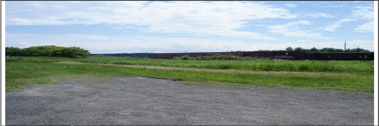
Aperçu de la zone industrielle comprenant la gare de triage, située au cœur de la Ville de Farnham
