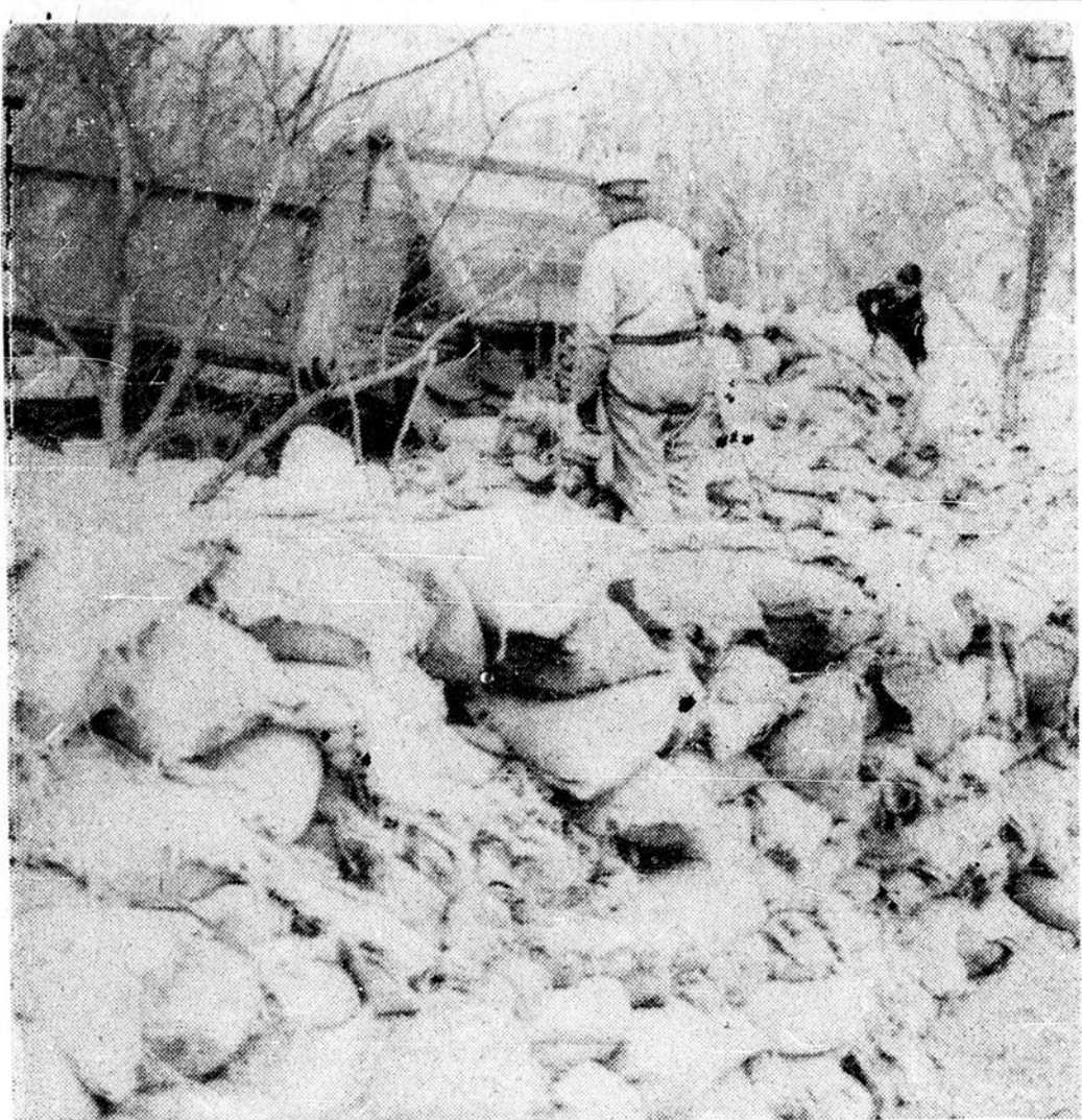
LES EAUX MONTENT DANGEREUSEMENT — Des équipes ont travaillé durant toute la fin de semaine à ériger des barrières de sacs de sable en bordure des rues de Winnipeg, alors que les eaux de la rivière Rouge ne
