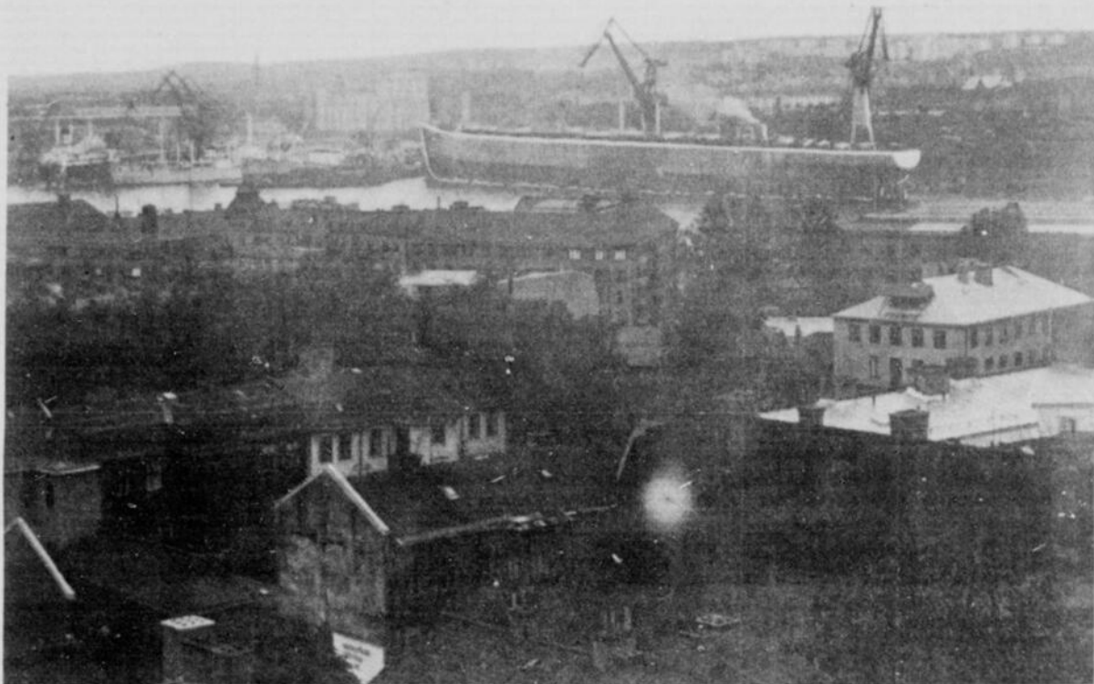
Les chantiers maritimes de Göteborg (Suède) ont adopté la formule américaine de construction de navires par sections. Ci-haut, un pétrolier de 250,000 tonneaux qui prendra la mer d'ici une année.
