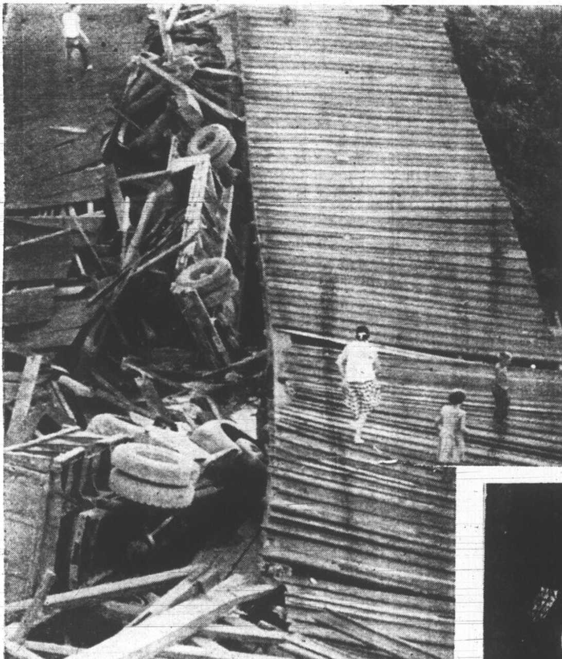
Un autre pont qui disparaît — Vendredi, c'était un vieux pont en bois qui s'écroulait dans la province de Québec; samedi, un pont s'écroulait à Thomaston, en Georgie, au moment où deux camions, dont l'un transportait un "bull-dozer", le traversaient. Comme son "cousin" de Wakefield, le pont américain était en bois et fort vieux. Par bonheur, personne ne fut blessé dans l'accident. Ci-haut, les débris photographiés dans la rivière. (Téléphoto United Press — "Montréal-Matin")
