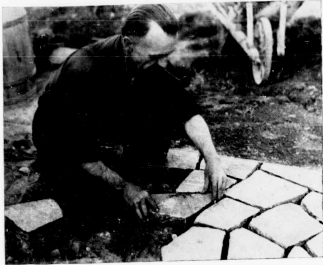
M. Léon Parent, machiniste dans l'atelier de l'électricité de l'usine, occupé à construire son trottoir, en face de sa maison, au no 574, rue Hunt, à Arvida.
