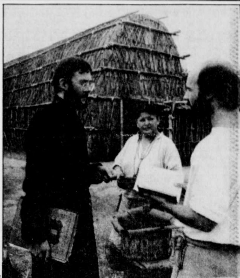
La reconstruction de Sainte-Marie-des-Hurons a débuté dans les années 1960. En arrière-plan, une réplique de l'hôpital de la mission qui s'était établie au nord de Toronto en 1639.
