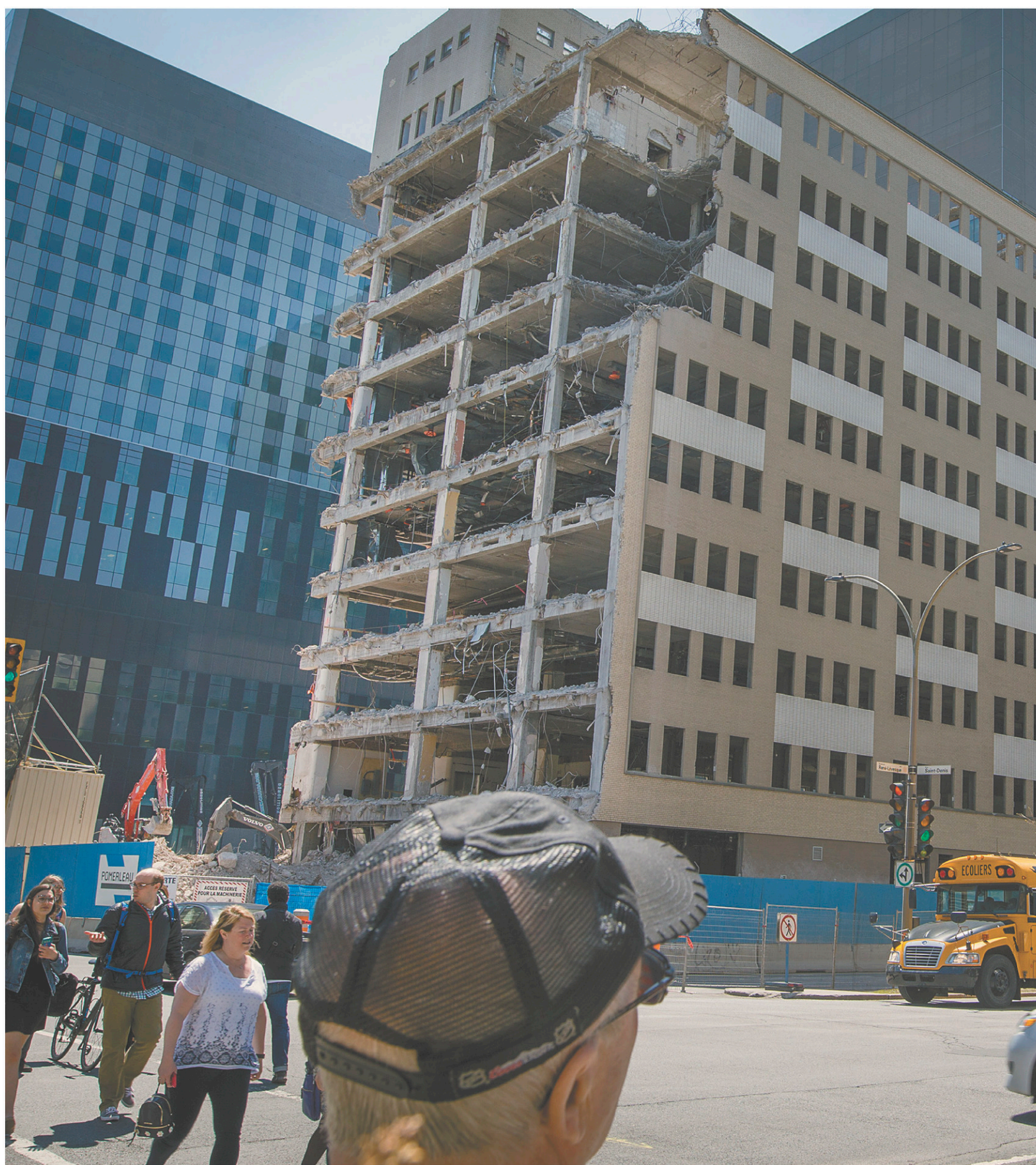
Les murs de brique jaune caractéristiques de l'hôpital Saint-Luc disparaissent un peu plus chaque jour, égrainés par un bras mécanique.
