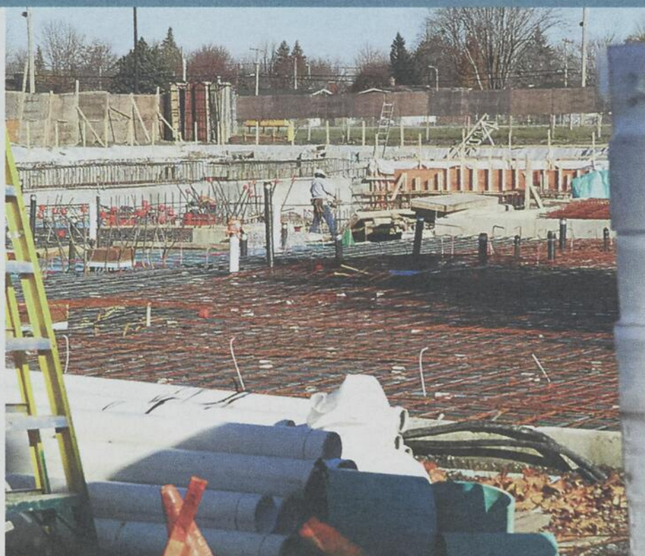
L'érection de la structure du Centre récréoaquatique devait commencer ces jours-ci. Photo Patrick Roger | Le Courrier ©
