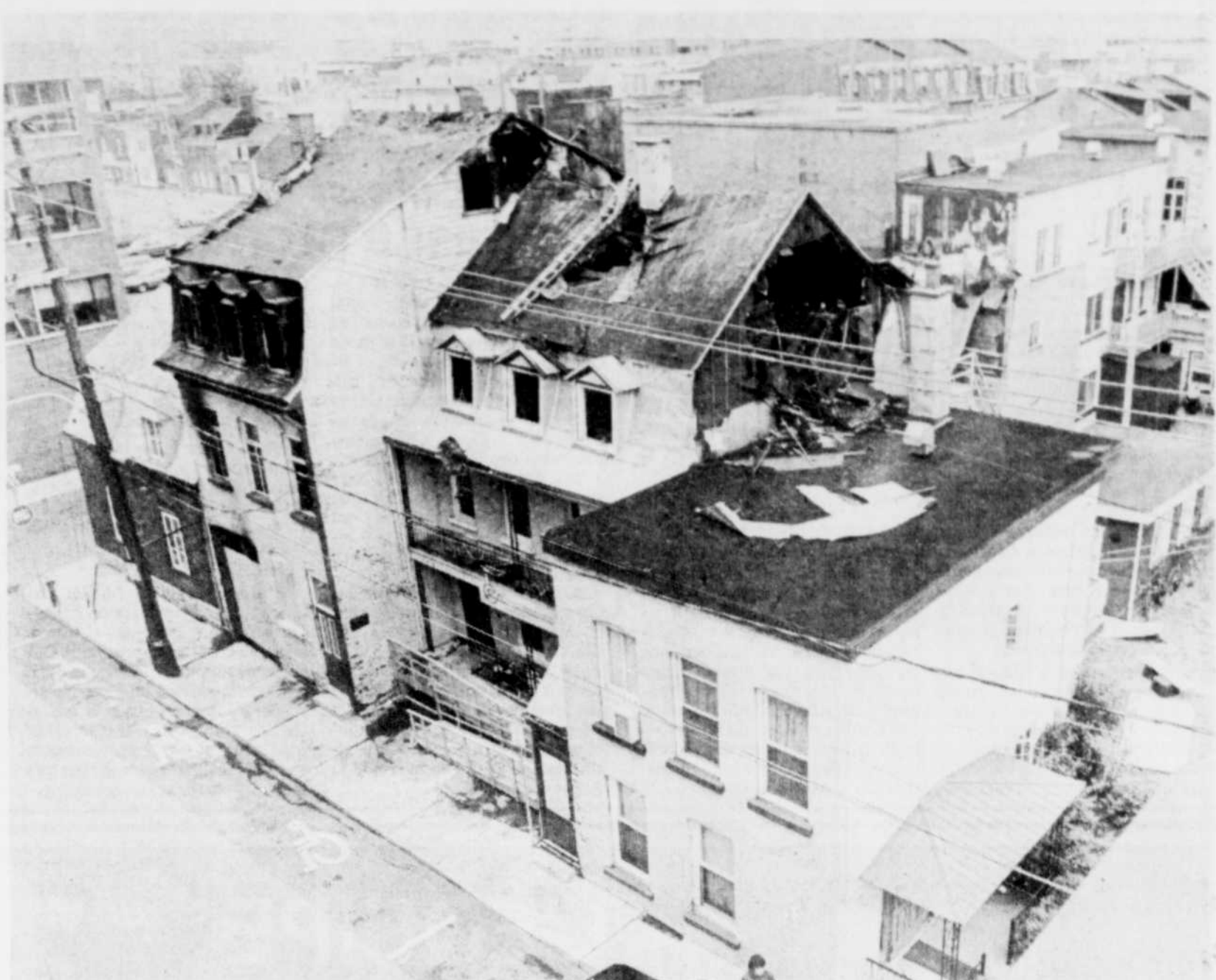
Seule la maison du coin, à gauche sur la photo, a été épargnée par l'incendie.
