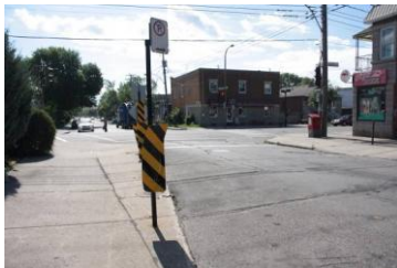
Avancée de trottoir
