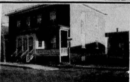
ZONAGE ADEQUAT POUR UN COMMERCE Propriété de 2 logements, extérieur en briques. Centre-ville, St-Robert.
