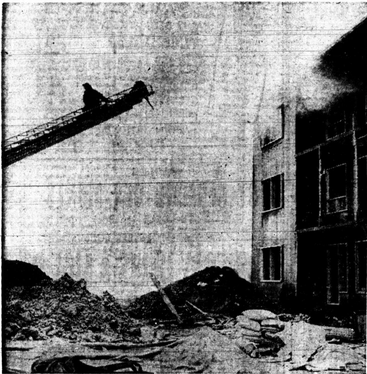
DES MILLIERS DE TONNES D'EAU — Des milliers de tonnes d'eau ont été versées sur les maisons à demi construites et les piles de matériaux de construction. Tous les ouvriers à l'exception des trois mentionnés ailleurs ont pu se sauver à temps et éviter d'être blessés. (Photo "Montréal-Matin" par Bernard Beauvais)
