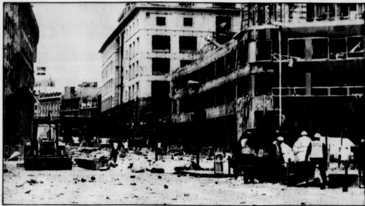
Plusieurs bâtiments ont été endommagés et les rues étaient tapissées de débris de verre.
