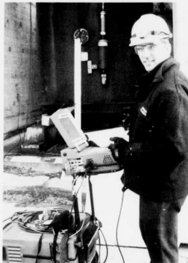
Bernard St-Laurent, électricien à la centrale de Shipshaw, effectue un test d'isolation en utilisant un aide-mémoire.
