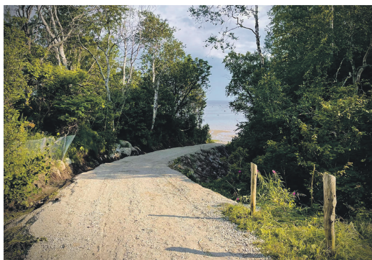
La descente vers la plage près de la base de plein-air des Bergeronnes a été remise en état. Photo Facebook
