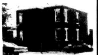
62 Aqueduc 2 loyers finition brique
