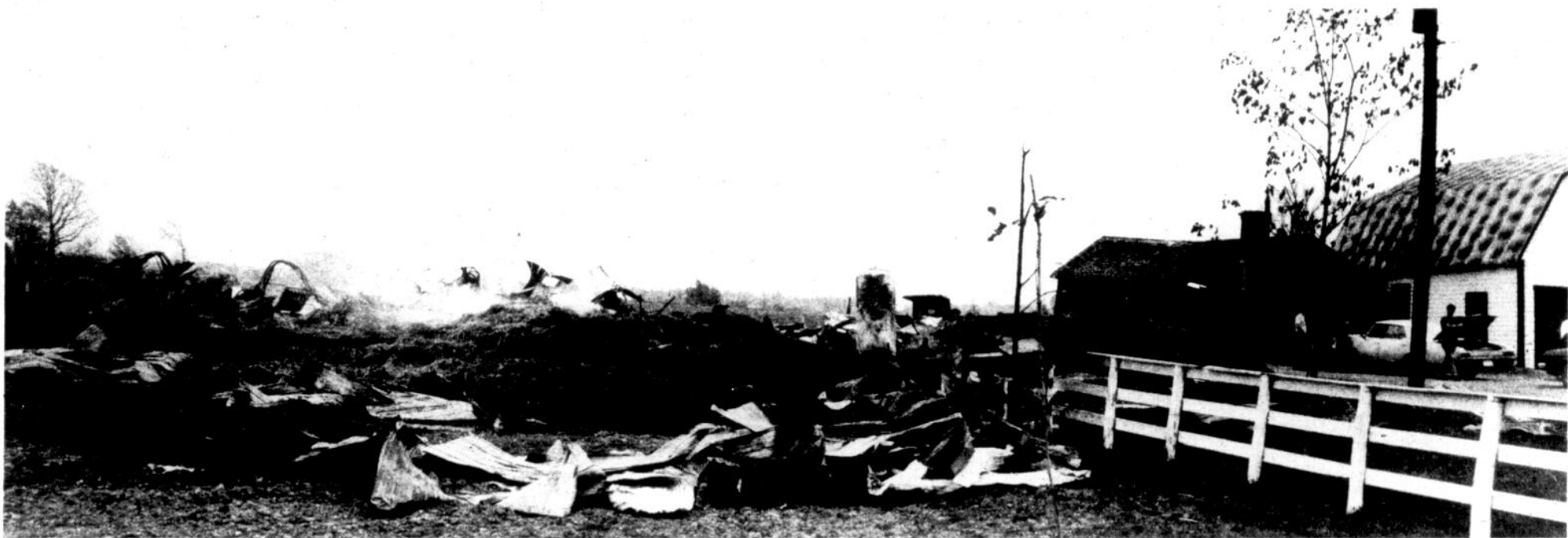
La grange-étable de M. Rolland Thibodeau a complètement été rasée.
