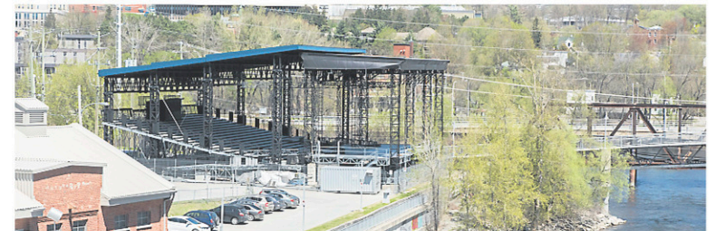
La place Nikitotek cèdera sa place à un parc linéaire dans le projet de déplacement du pont des Grandes-Fourches. — PHOTO ARCHIVES LA TRIBUNE
