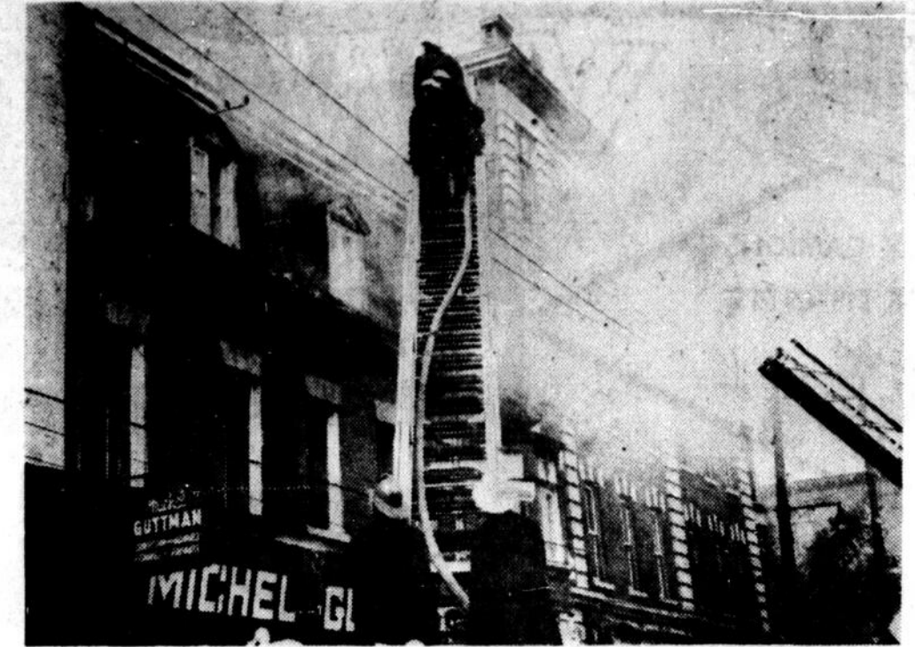
Les pompiers ont dû faire des brèches dans la toiture pour combattre plus efficacement les flammes.
