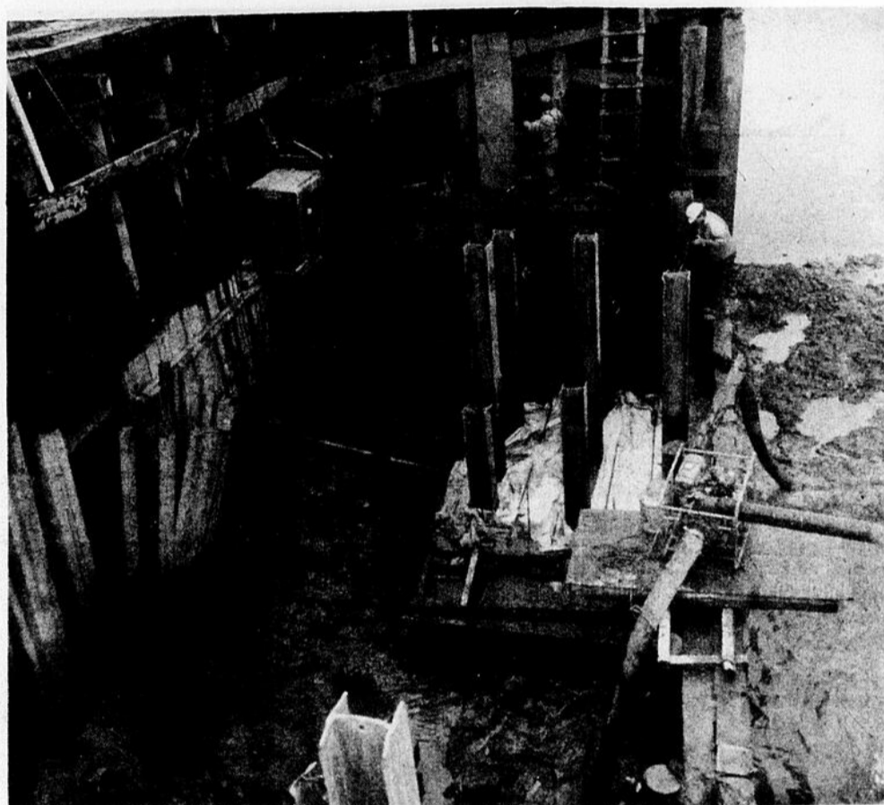
On a éventré la partie en bois du quai de Montmagny pour y installer un embarcadère d'une capacité de levage de 35 tonnes.
