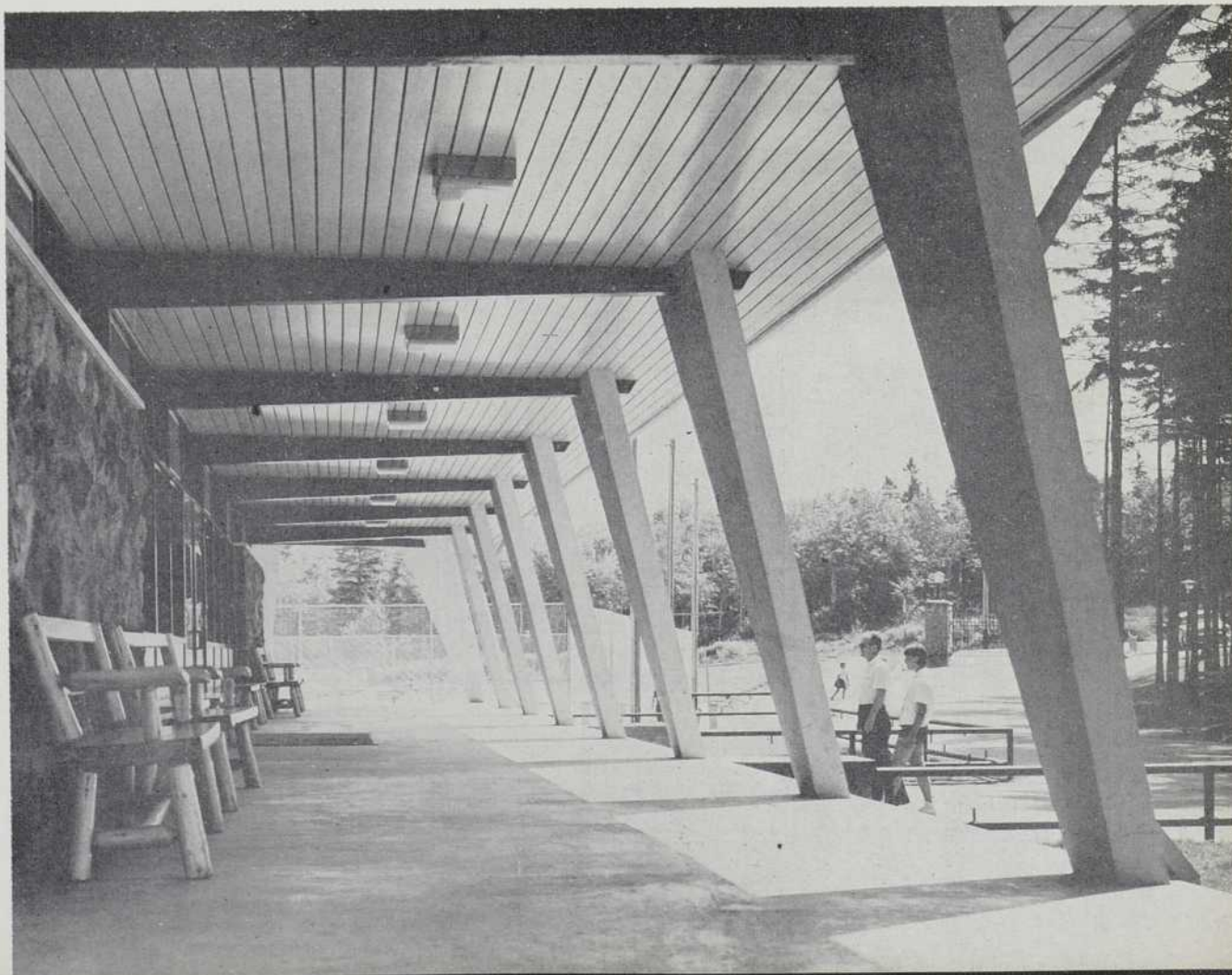
4 et 5 — Vues extérieure et intérieure de la galerie qui entoure le chalet et qui mettent en relief les cadres de sa structure.
