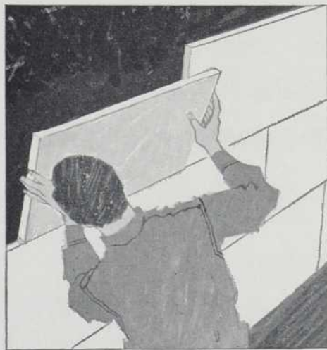
2. Pressez Styrofoam en place.
