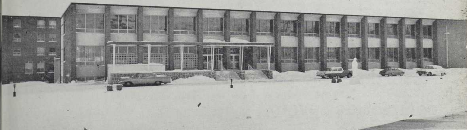
Collège Marymount, Ste-Foy, Québec. — ARCHITECTES : Gaston Amyot et Edouard Fiset. ENTREPRENEURS GÉNÉRAUX : Cimota Construction Corp. Ltd. L'Ascenseur à passagers Rotary Oildraulic vendu et installé par Alpin Elevators Co., Ltd.
