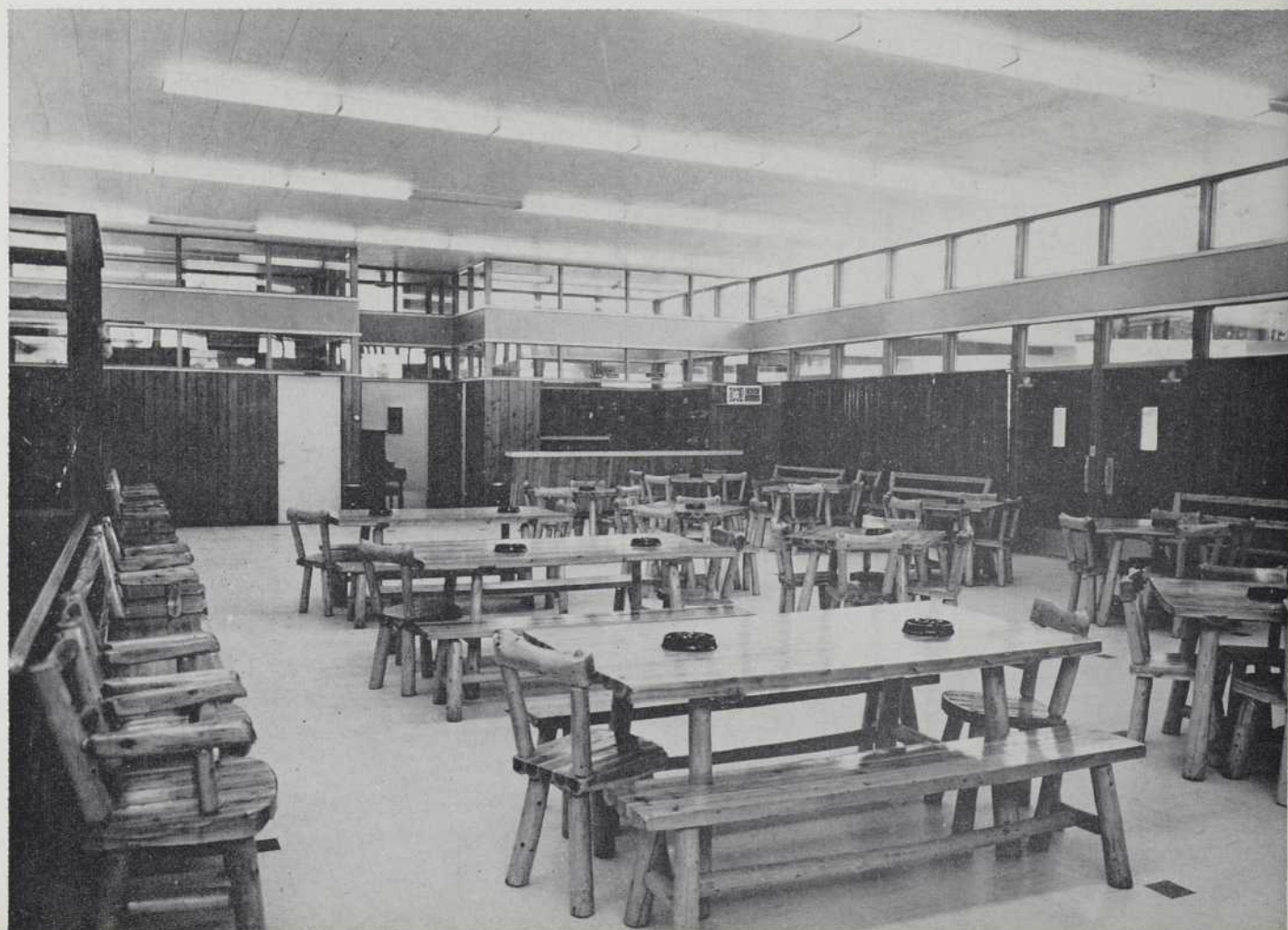
Salle du rez-de-chaussée, exempte de colonnes. Au fond, à gauche : le bureau de l'administration; à droite : le restaurant.
