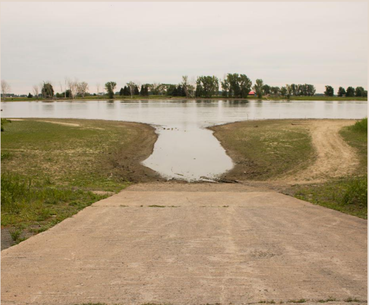
Rampe de mise à l'eau au parc Saint-Laurent à Repentigny, 25 juin 2021. Crédit photo : Joani Hotte-Jean.
