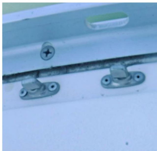
L'installation avec des rivets pop.
