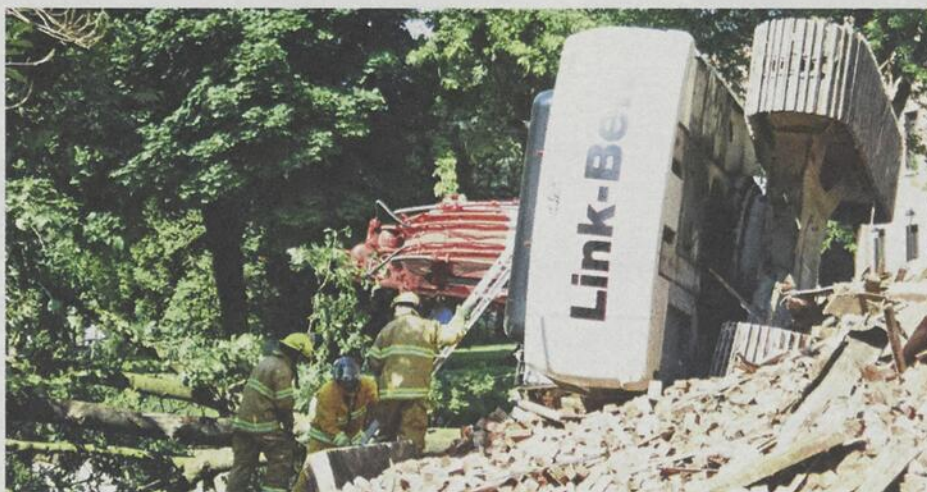
La démolition de la Maison Dessaulles a été plus complexe que prévu. Le renversement de la pelle mécanique a entraîné une série d'incidents. Le Courrier
