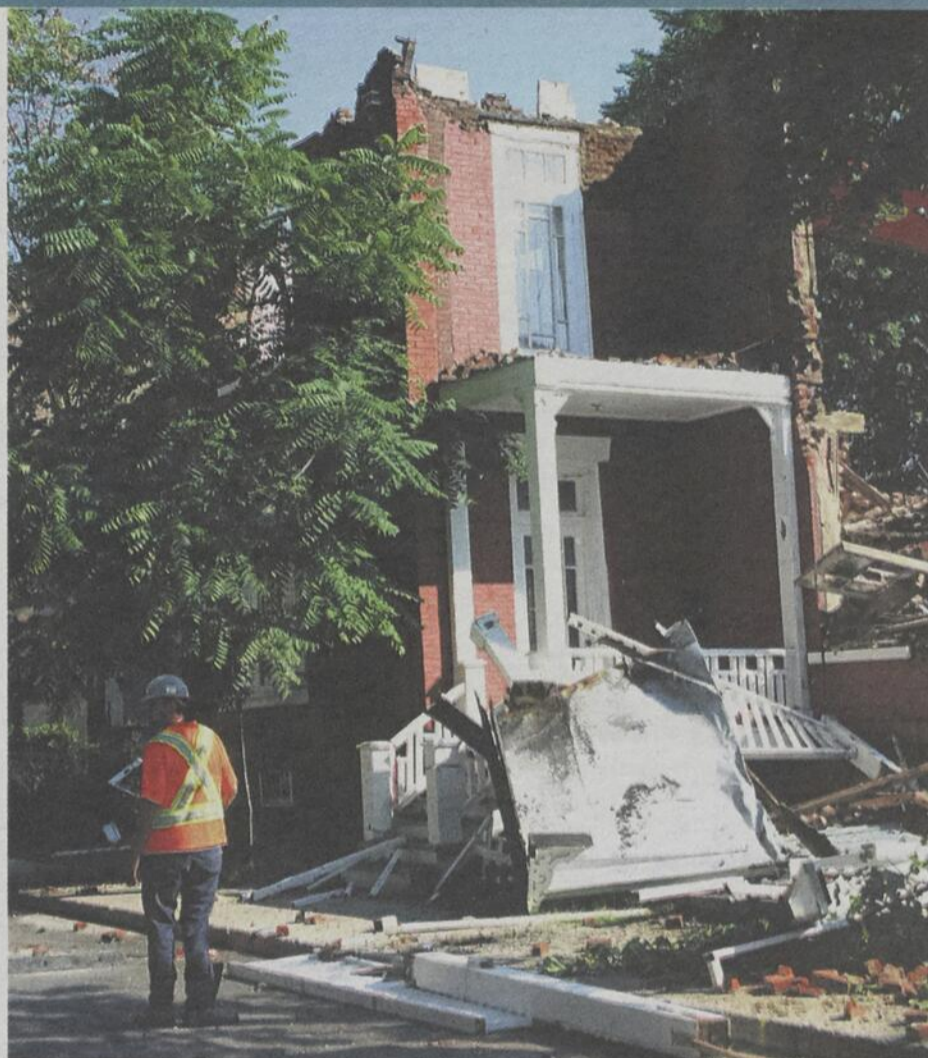
La Maison Dessaulles n'a pas résisté longtemps au pic des démolisseurs.
