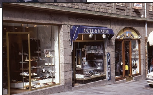
43 et 44. Saint-Malo. Contraste entre les maisons reconstruites le long des remparts et celles des rues et places du centre, animées par des devantures commerciales. (Photos Luc Noppen)
