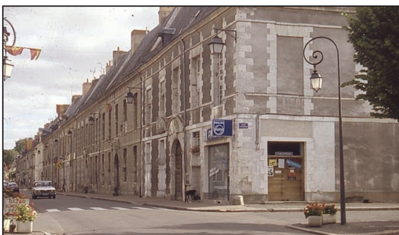
32. Richelieu. Rue principale de la ville nouvelle avec immeubles résidentiels dotés de portes cochères et percements modernes à des fins commerciales, en coin de rue. (Photo Luc Noppen)
