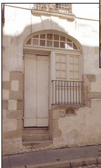
49 et 50. Vannes (ci-dessus), Nantes (ci-contre) Ouvertures en arcade et sous sablière. (Photos Luc Noppen)
