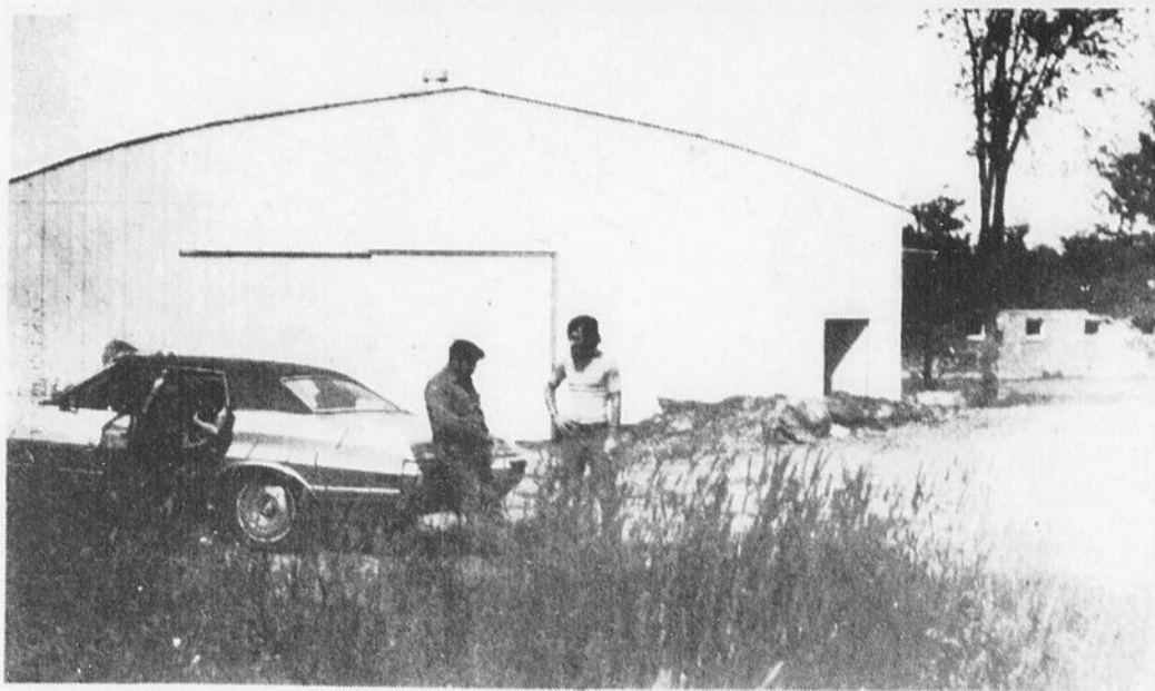
L'écurie ultra-moderne de la S.A.M. est complètement terminée depuis quelques mois déjà, seul le haut reste à aménager. On aperçoit une vue d'ensemble de la bâtisse, avec à l'avant plan des responsables qui étudient les possibilités d'aménagement extérieur.
