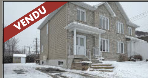
LÉVIS, 6213 RUE MASSENET
