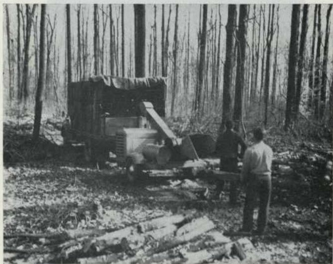
Fig. 8 — Coupeuse ("Chipper") mobile, servant à la transformation des résidus de bois en copeaux.
