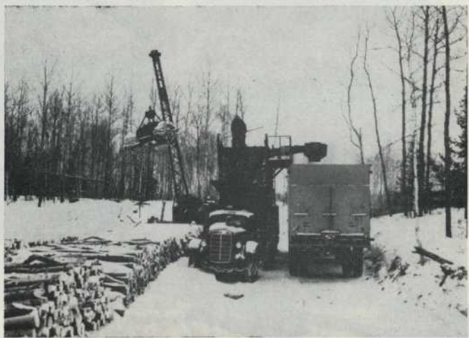
Fig. 25 — Cyclone mobile pour le chargement des copeaux.
