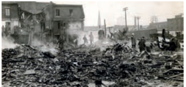
Le travail des pompiers sur la rue Shannon.
