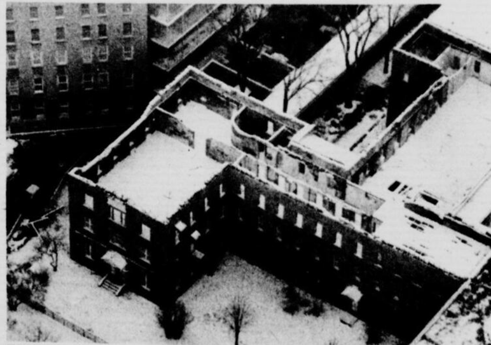
Voici une vue aérienne des dégâts causés au pavillon Bourget de l'hôpital Louis-Hippolyte Lafontaine. Cette photo a été prise en hélicoptère au lendemain de l'incendie qui a mobilisé de nombreux pompiers et policiers pour lutter contre le fléau et procéder à l'évacuation des malades.
