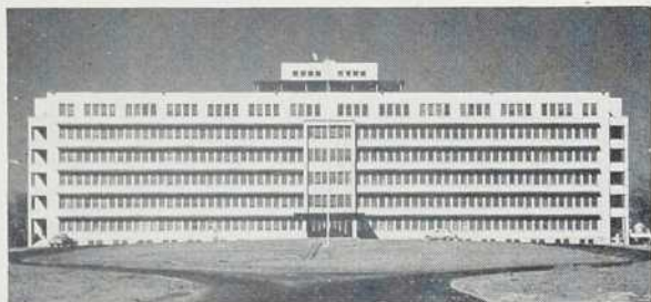
Façade de l'Hôpital St-Louis-Marie de Montfort, à Ottawa. (Jean-Serge Lefort, architecte.)
