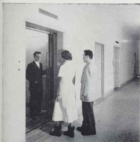
les ascenseurs qui font face à l'entrée principale sont à grande vitesse. La porte du centre est celle du futur ascenseur à passagers.
