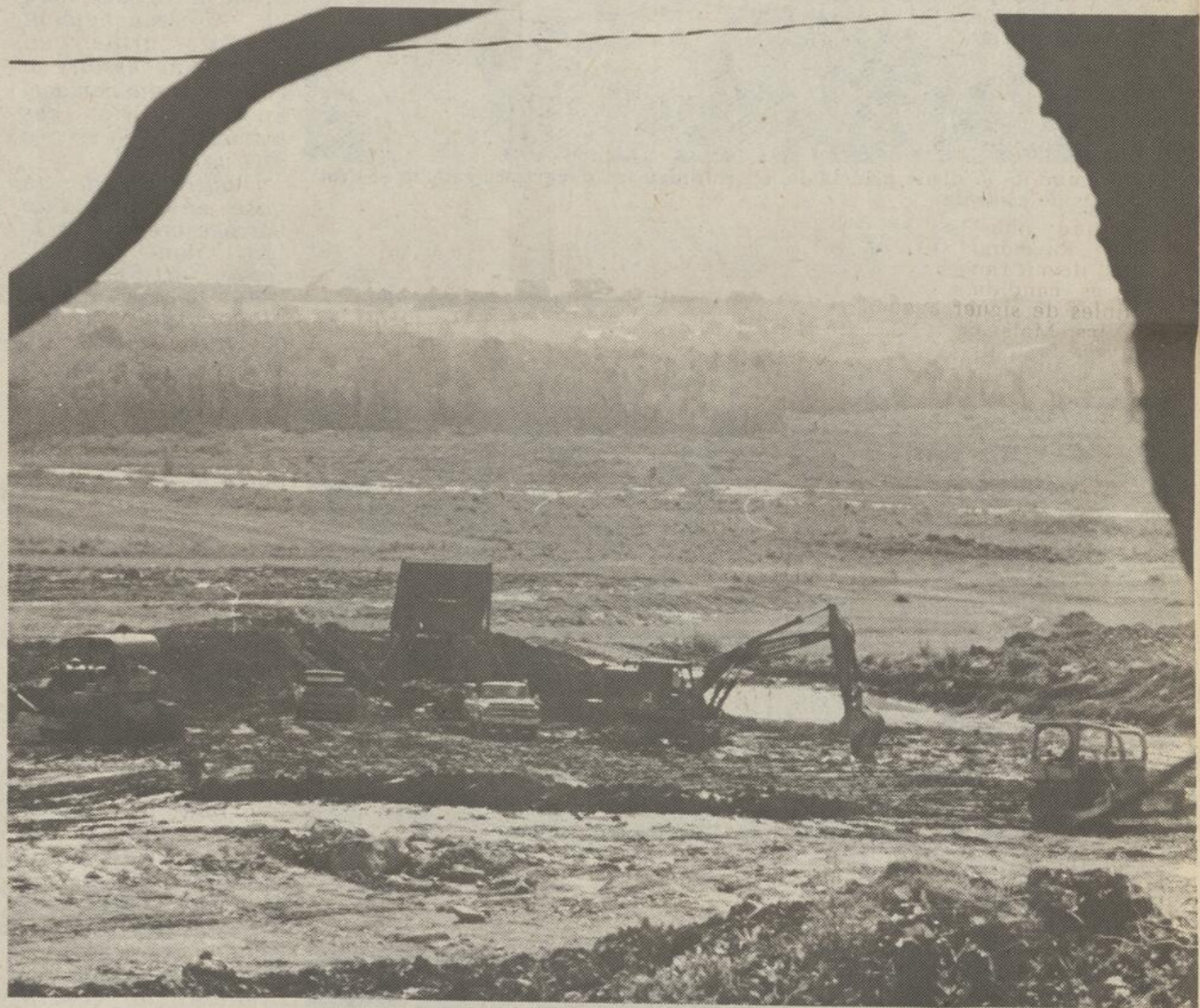
A la veille de prendre fin, la première phase comprend le déboisement et l'essouchement d'une partie du territoire nécessaire à l'érection du barrage-réservoir.
