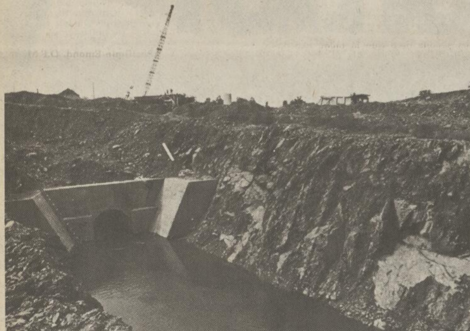
La galerie souterraine de dérivation des eaux de la rivière Yamaska compte 850 pieds de longueur. L'entrée du tunnel, que l'on aperçoit sur la vignette, mesure 9 pieds de diamètre.
