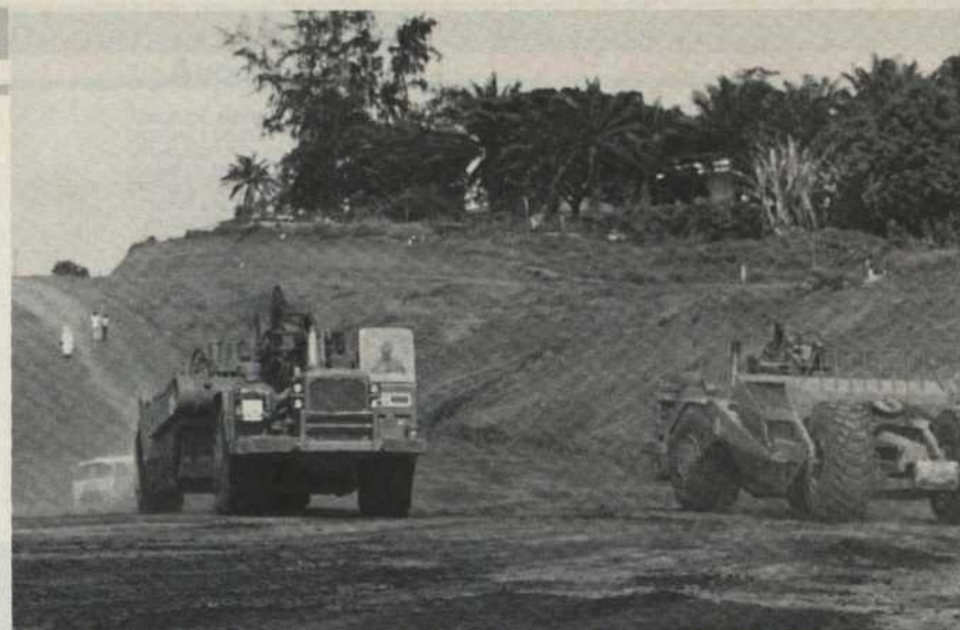
Chantier routier en Côte d'Ivoire.
