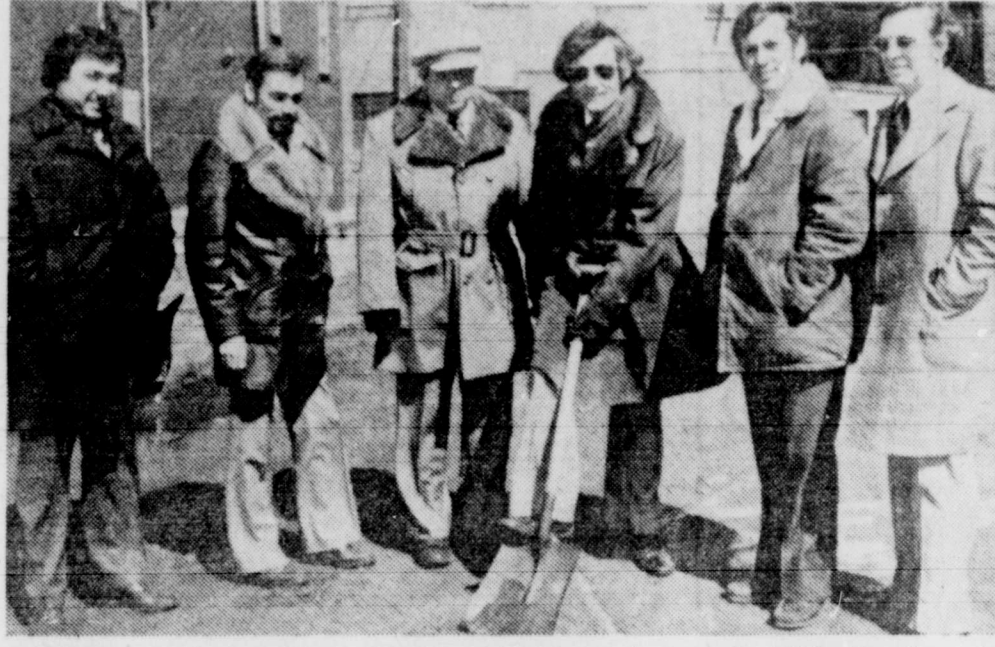
Voilà que débutent ce matin les travaux d'agrandissement et de rénovation à l'hôtel des Chutes, située sur le boulevard Saint-Maurice à Shawinigan. Le coût total des travaux s'élève à $365,000. Sur la photo, le maire Dominique Grenier procède au geste symbolique de la première pelletée de terre. Nous reconnaissons de gauche à droite: MM. André Caron, de Caron Construction inc.; Robert Trudel, secrétaire-trésorier de l'hôtel des Chutes; Charles Mills, président; Pierre Lavergne, directeur et Camille Descôteaux, directeur-général de l'hôtel des Chutes inc. (Photo Normand Rheault)
