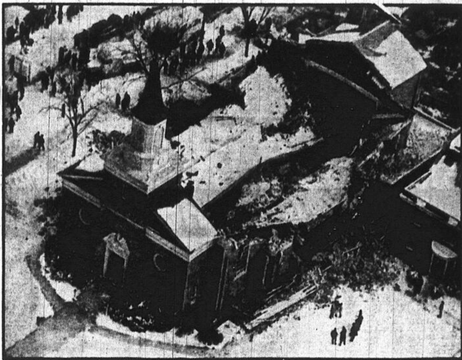
Une vue aérienne de la petite église Ste-Rose-de-Lima de Baltimore après l'effondrement du toit hier matin. (UPI-MM)
