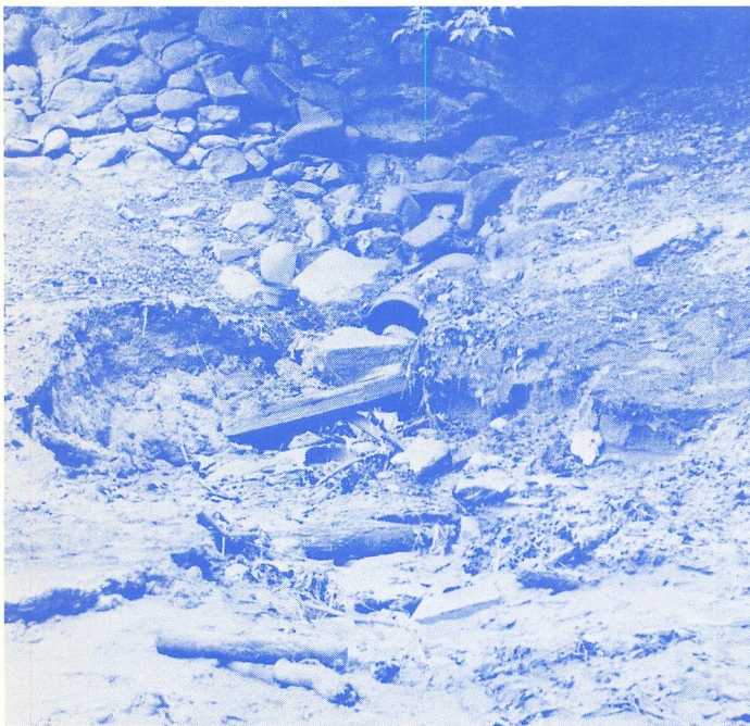
Le niveau de l'eau avait été abaissé... (p.18)
