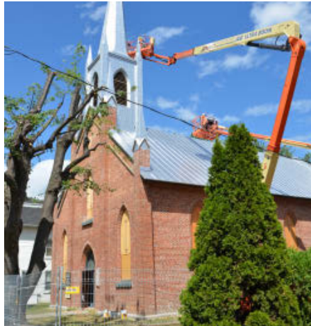
La phase 2 des travaux comprenait notamment la réparation du toit.
