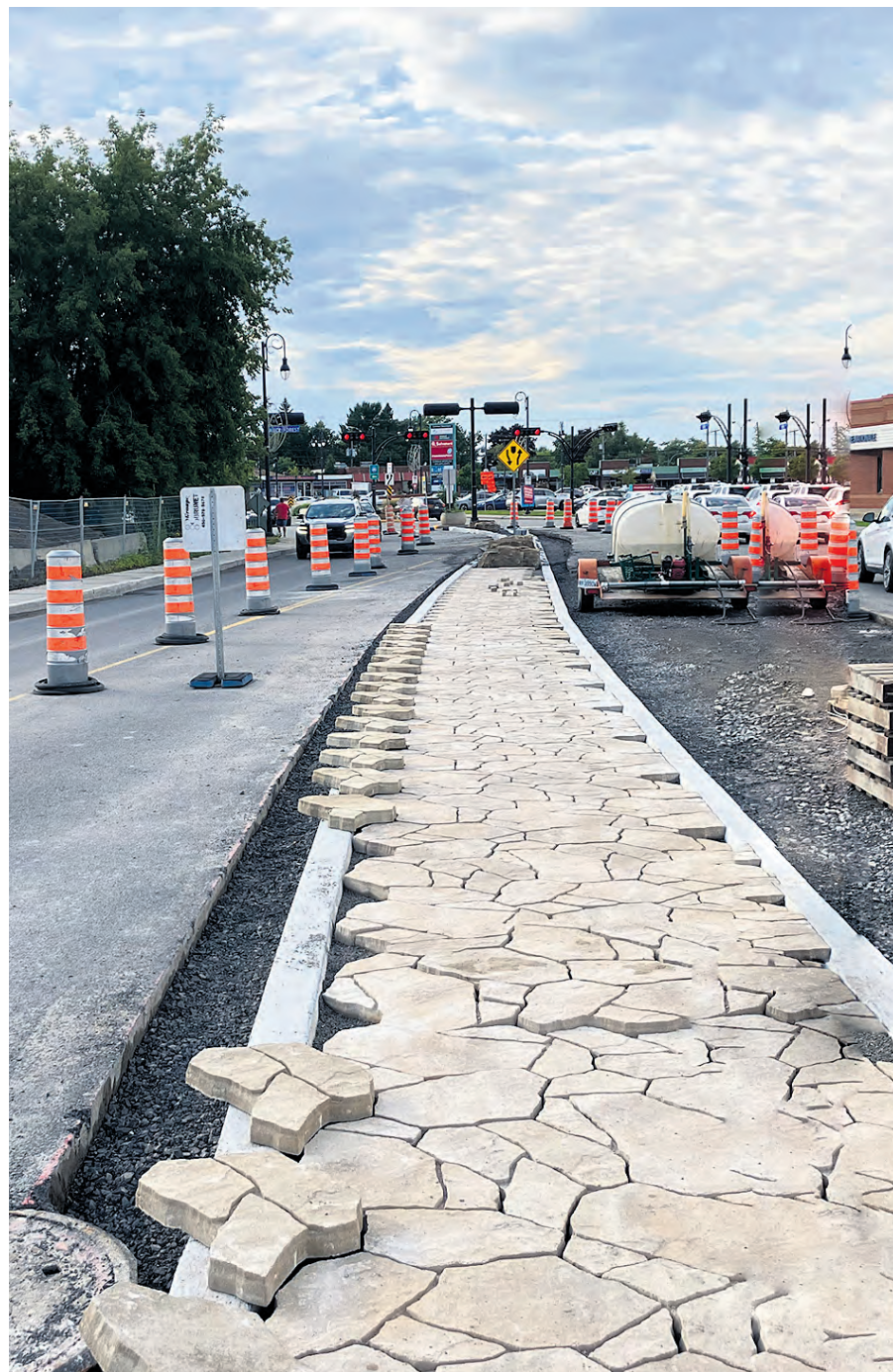
La prochaine étape, qui consiste à appliquer la couche d'asphaltage finale sur les 4 voies.
