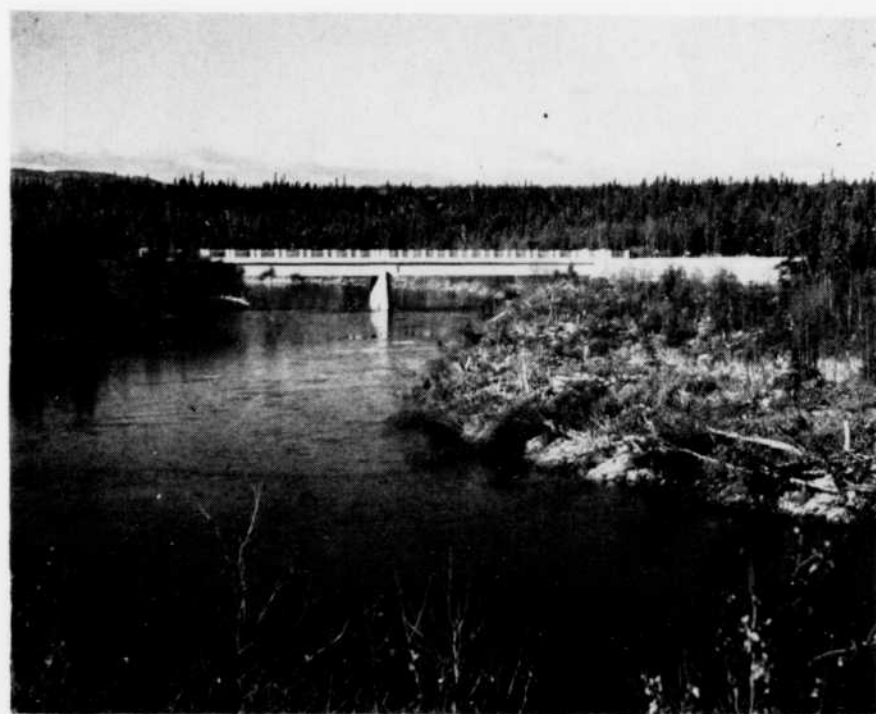
Fig. 8 — Sur la rivière Riverin, Comté de Saguenay. Pont à poutres profilées comprenant 2 travées simples de 100 pieds.
