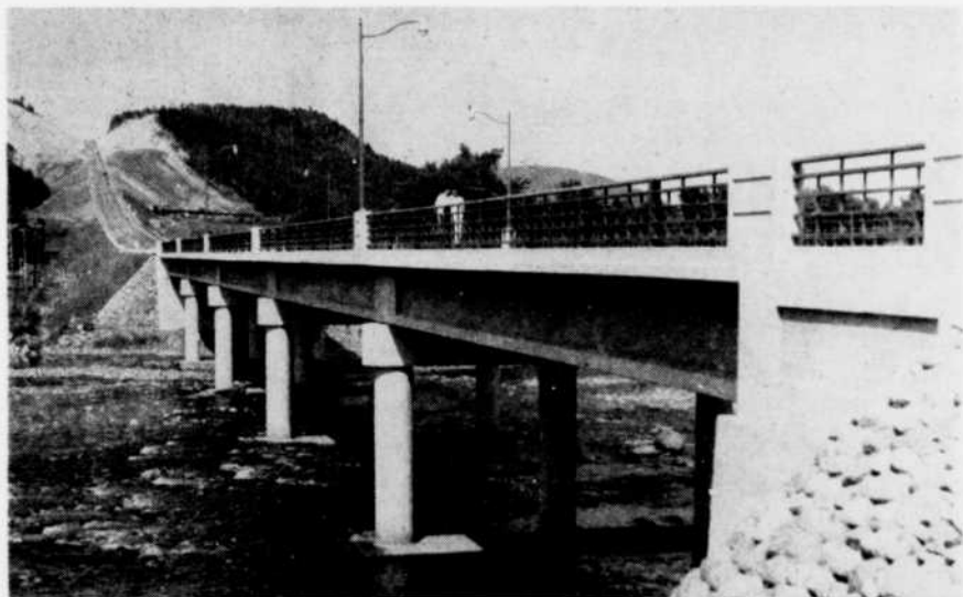
Beaupré, Rivière Ste-Anne (1956). Travée de 100 pieds avec poutres à semelles.
