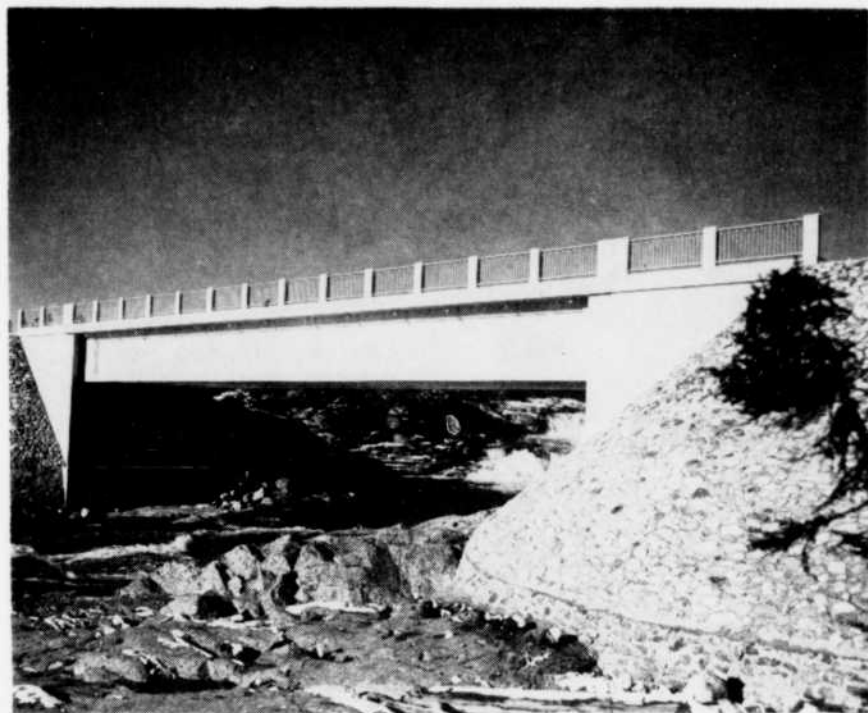
Fig. 10 — Sur la rivière aux Rochers, Comté de Saguenay. Pont à poutres profilées d'une portée de 125 pieds. Au moment de sa construction, c'était la plus grande travée simple au monde.
