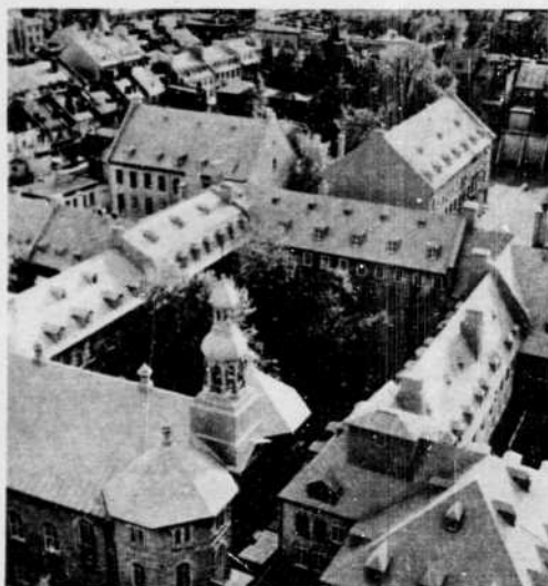
Vue aérienne des bâtiments qui forment le couvent des Ursulines et dont le plus ancien date de 1686.
