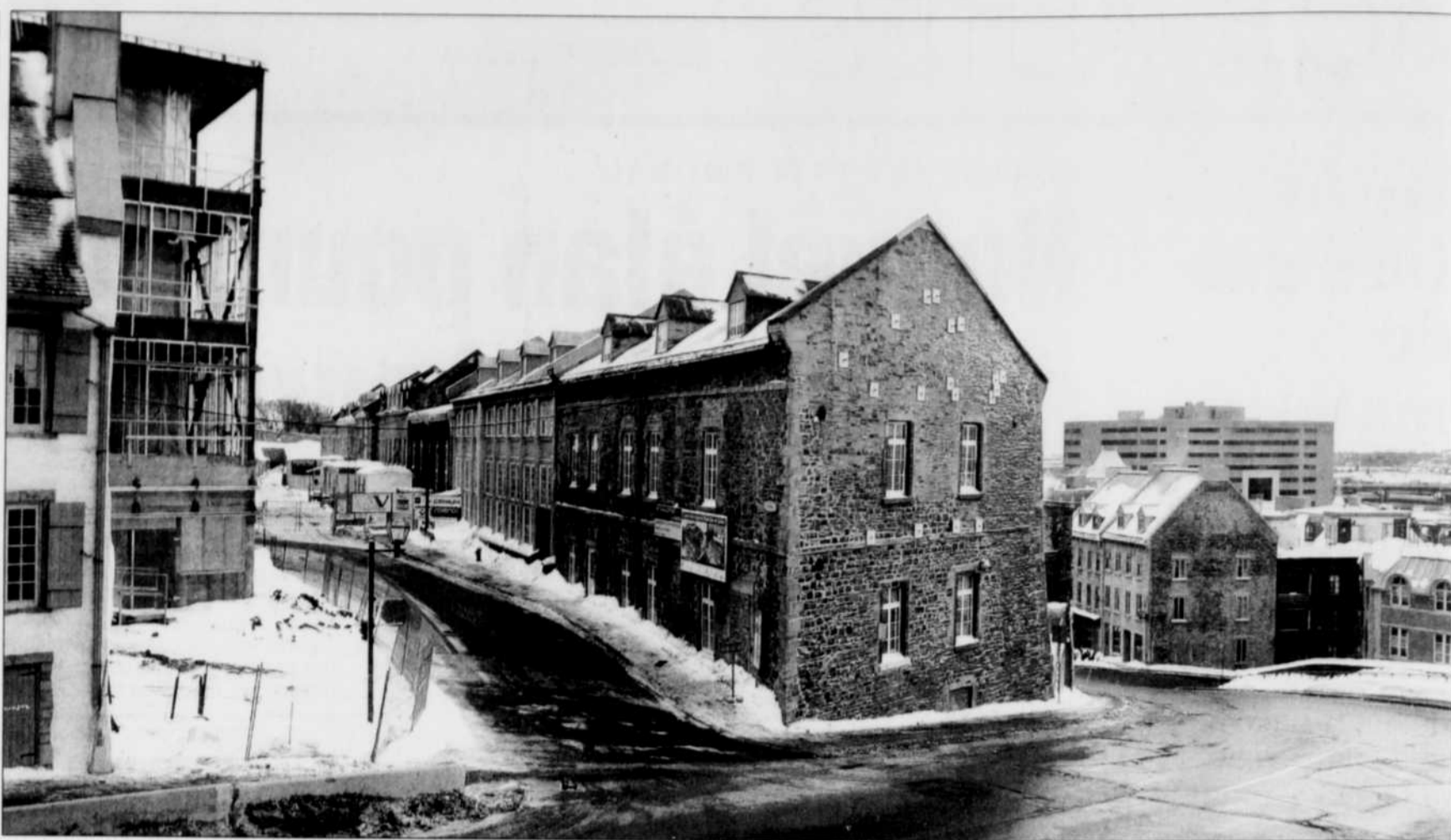
Construites au milieu du XVIII e siècle, sous le règne de Louis XV, selon les plans de Gaspard-Joseph Chaussegros de Léry, les Nouvelles Casernes se démarquaient de ce qui se faisait à l'époque en termes d'architecture militaire.
