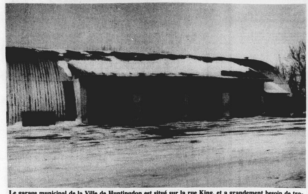
Le garage municipal de la Ville de Huntingdon est situé sur la rue King, et a grandement besoin de travaux de réfection.
