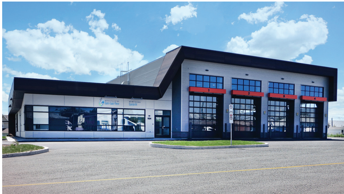
La caserne de pompiers de Havre-Saint-Pierre a été inaugurée en 2017. (Photo : DMG Architecture)
