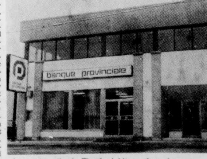
Le centre-ville de Thetford Mines s'est récemment enrichi d'un édifice ultra-moderne où sont présentement logés les locaux de la nouvelle succursale de la Banque Provinciale. Incidemment, une réception soulignait hier soir le début des activités de cette entreprise bancaire. (Photo La Tribune, Thetford Mines)
