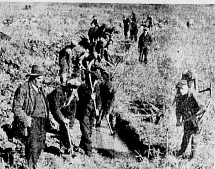
Hier aussi ont commencé à Lachine les travaux de chômage. Environ 300 chômeurs ont pris l'ouvrage. Notre photo nous montre un groupe d'employés occupés au creusement préliminaire à l'aménagement d'une piscine pour les enfants, au Parc Lassalle. Au premier plan, à l'extrême-gauche on reconnaît M. J. Coré, le contre-maitre. (Photo CANADA)
