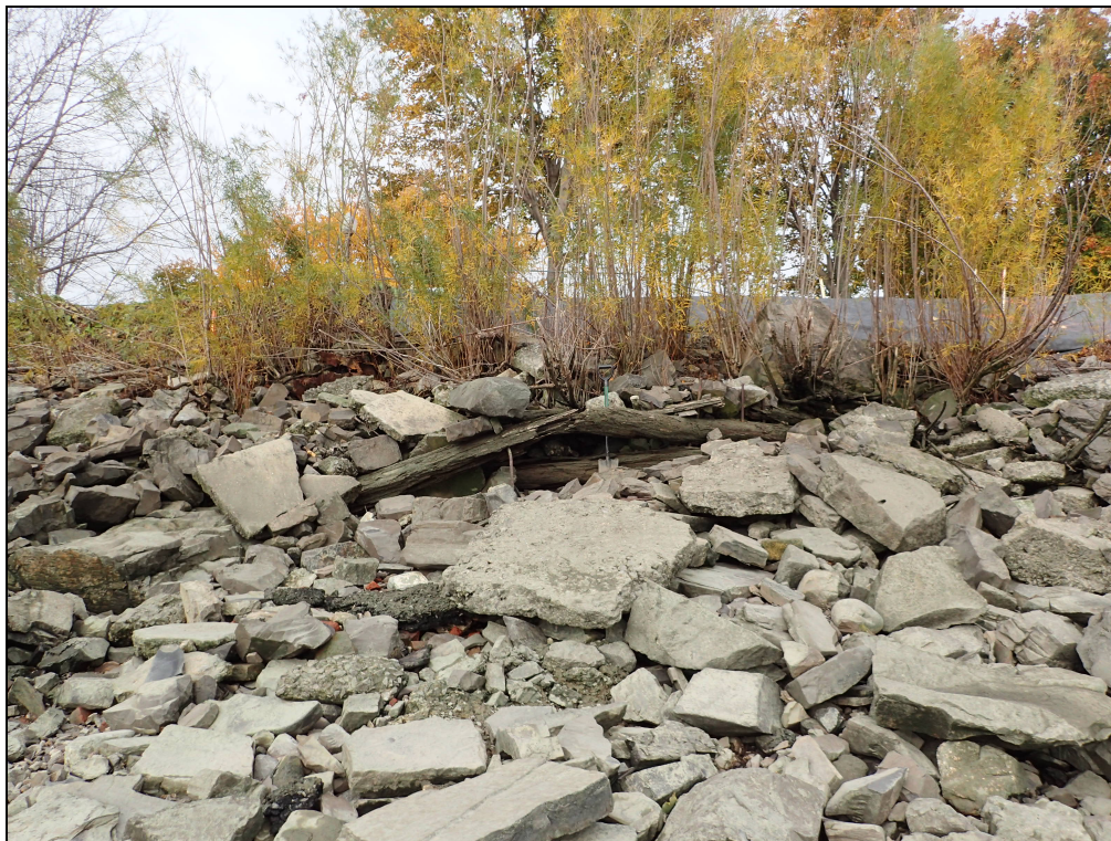
Figure 19. Vestige de quai 11A100, vers le nord-ouest (photo ARTE4-PA250118).
