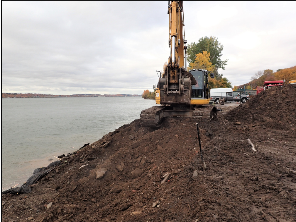
Figure 32. Remblais excavés dans la sous-opération 11B, vers le sud-ouest (photo ARTE4-PA190098).
