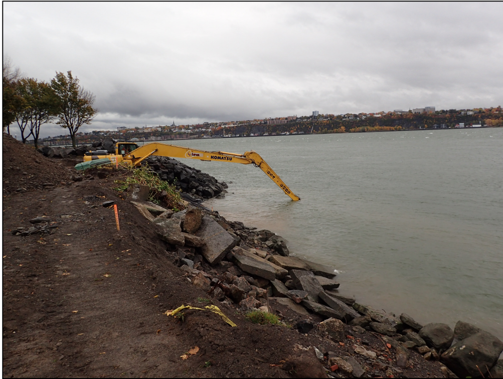
Figure 8. Excavation de la clé d’ancrage à marée montante, vers l’est (photo ARTE4-180087).
