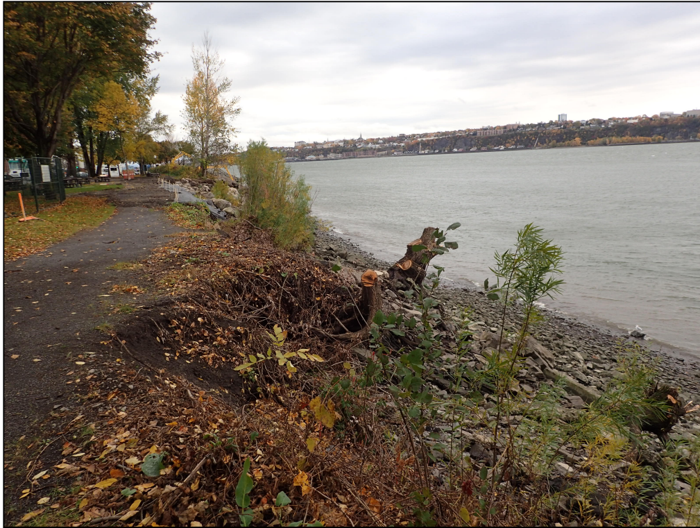
Figure 4. Vue générale de la sous-opération 11A, vers l'est (photo ARTE4-180092).
