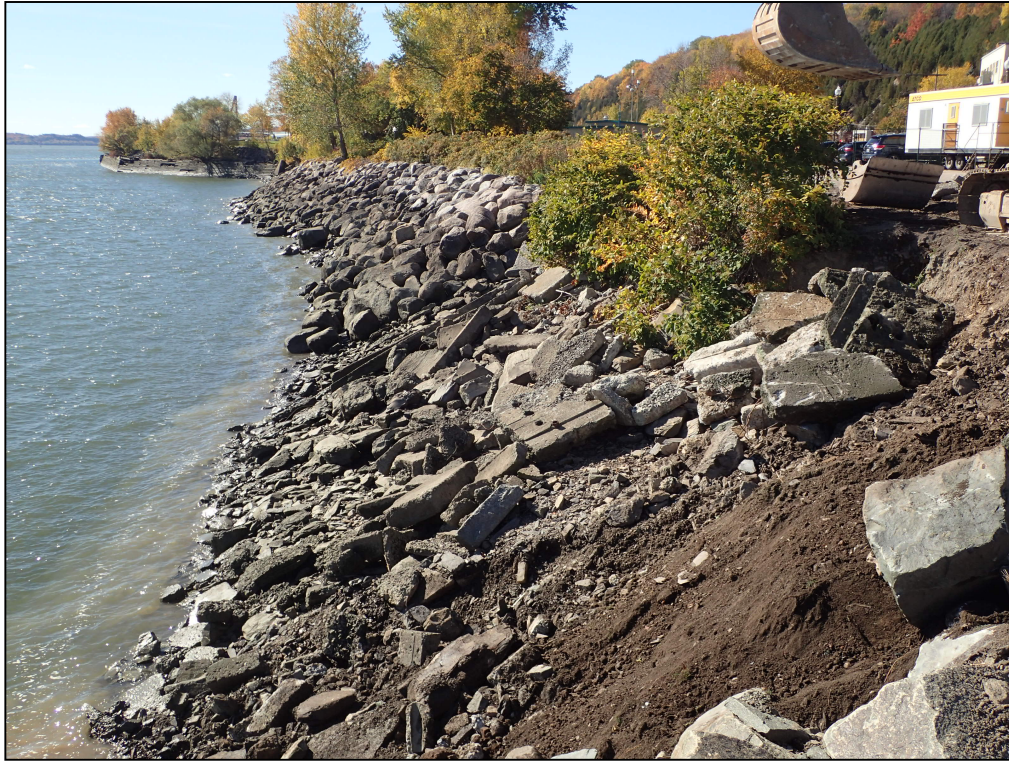
Figure 6. Vue générale de la sous-opération 11B, vers l'ouest (photo ARTE4-170081).
