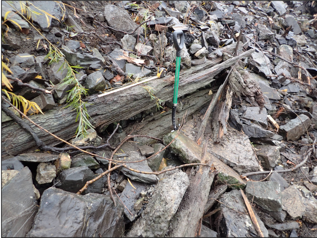
Figure 20. Agencement entre les deux parties de l'assemblage 11A100, vers le nord (photo ARTE4-PA260127).
