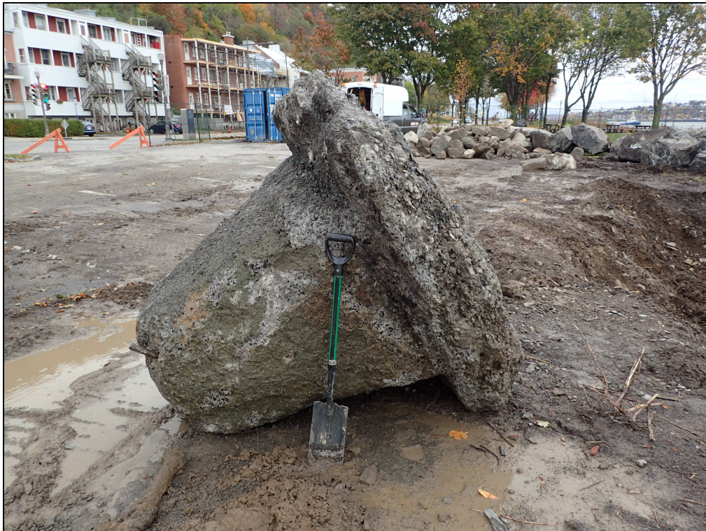
Figure 33. Base d'ancrage en béton, vers le nord-est (photo ARTE4-PA180093).
