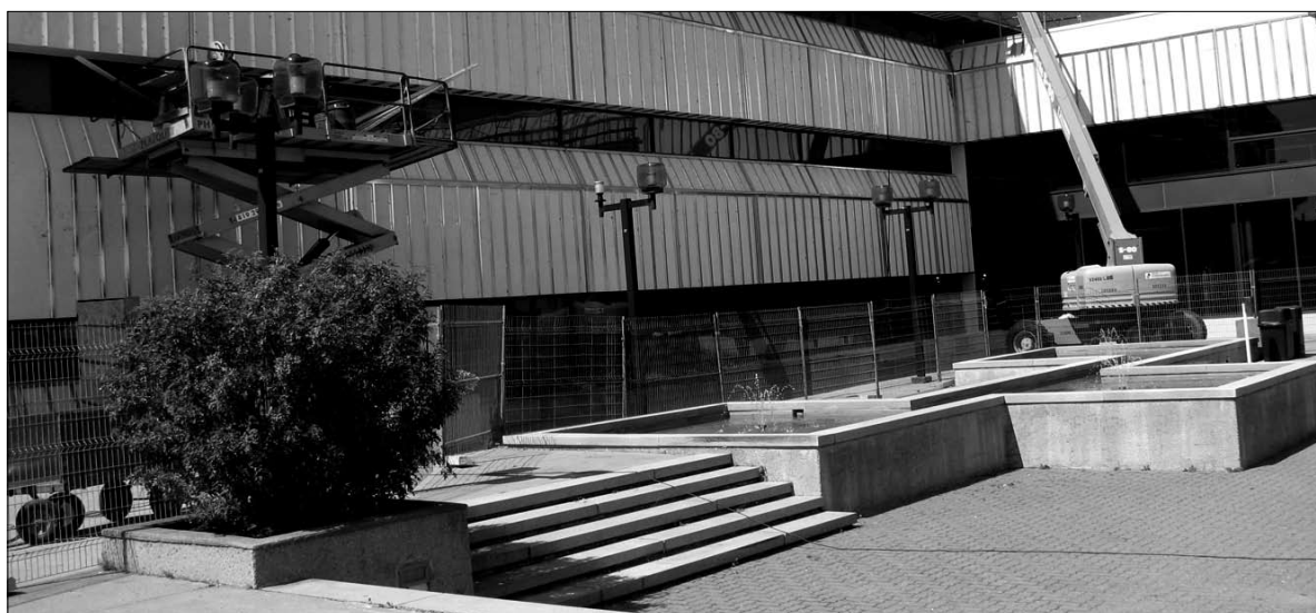
Rénovations de la façade extérieure du pavillon Albert-Tessier. Photo : M. Lemieux-Laramée
