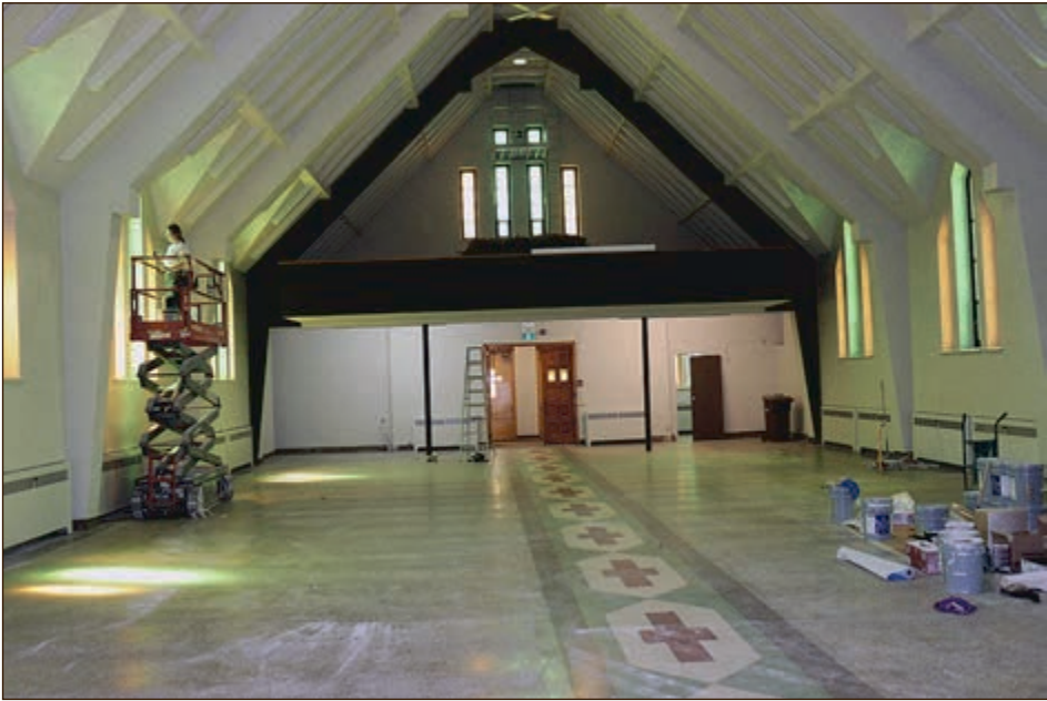
Les travaux de peinture dans leur phase finale
