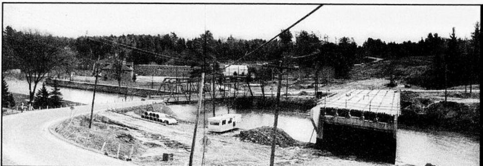
Le pont de fer du Rapide de Mascouche, près du domaine seigneurial, tel qu'il était quand on l'a remplacé par le nouveau pont en ciment, ici en construction au début des années 1990. (Photo : collection Aimé Despatis, CRAL)
