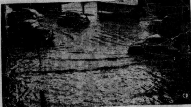
APPROCHES D'UN PONT BLOQUE PAR L'EAU — La Rivière Rouge, dont le niveau actuel dépasse tout ce qui s'était vu au Manitoba depuis un siècle, ferme les approches du pont Norwood, qui relie Winnipeg à St-Boniface, comme on le voit ici. Il en est de même pour le pont Provencher. (Cliché C.F.)
