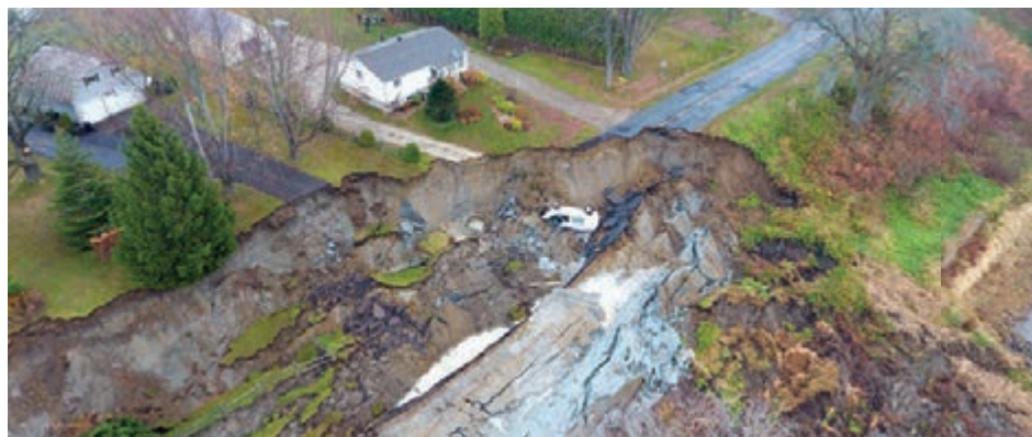
Vue aérienne d'une partie de l'affaissement.
