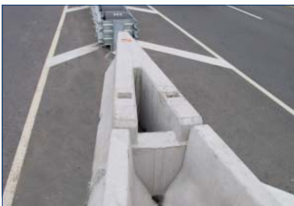
Photographie 3 Élément de raccordement en Y
